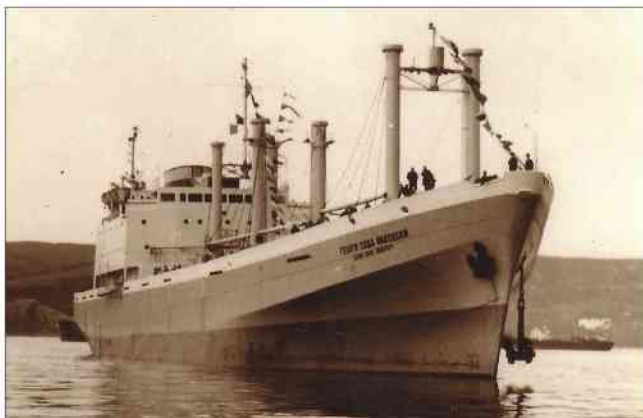
М/к „Г.С. Раковски“ е построен през 1960 г. в Глазгоу, Великобритания. DWT – 11 186, има дизелов двигател с мощност 5500 к.с. Дължина – 141,90 м; широчина – 19,25 м; височина на борда – 12,42 м; газене – 8,94 м. Излиза от експлоатация през 1983 г.
